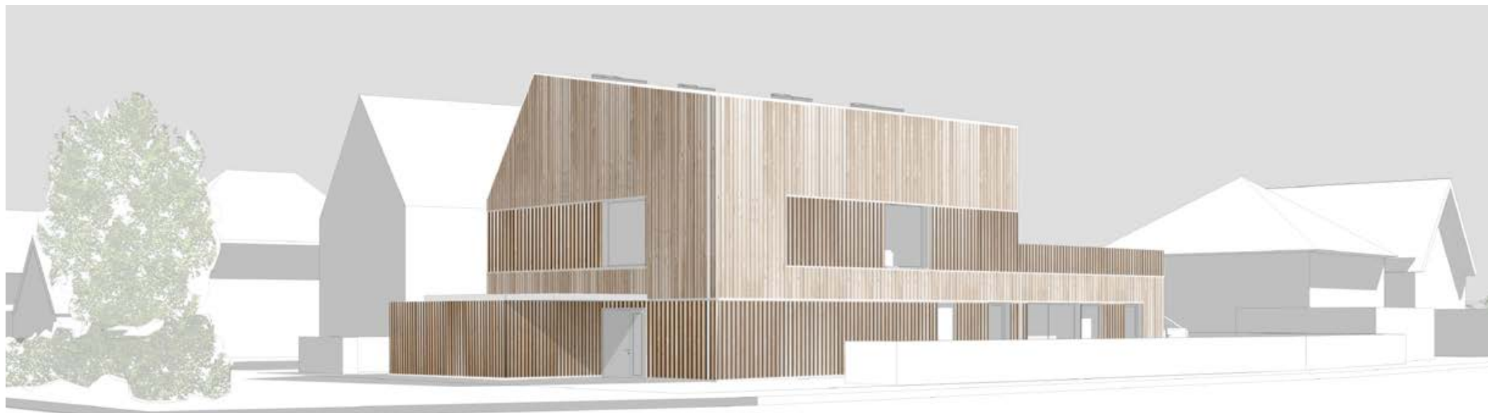
Platz für den Nachwuchs: Das neue Gebäude am Uhlhornsweg verfügt über 565 Quadratmeter Brutto-Grundfläche, verteilt auf zwei Vollgeschosse und ein Dachgeschoss mit Lager- und Technikräumen. Dank Holzbaweise, Erdwärmepumpe und Wärmetauschern ist der Neubau besonders energieeffizient.
