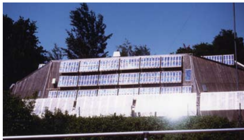
Der Beginn der Energieforschung an der Universität Oldenburg: das Energielabor auf dem Campus Wechloy.
