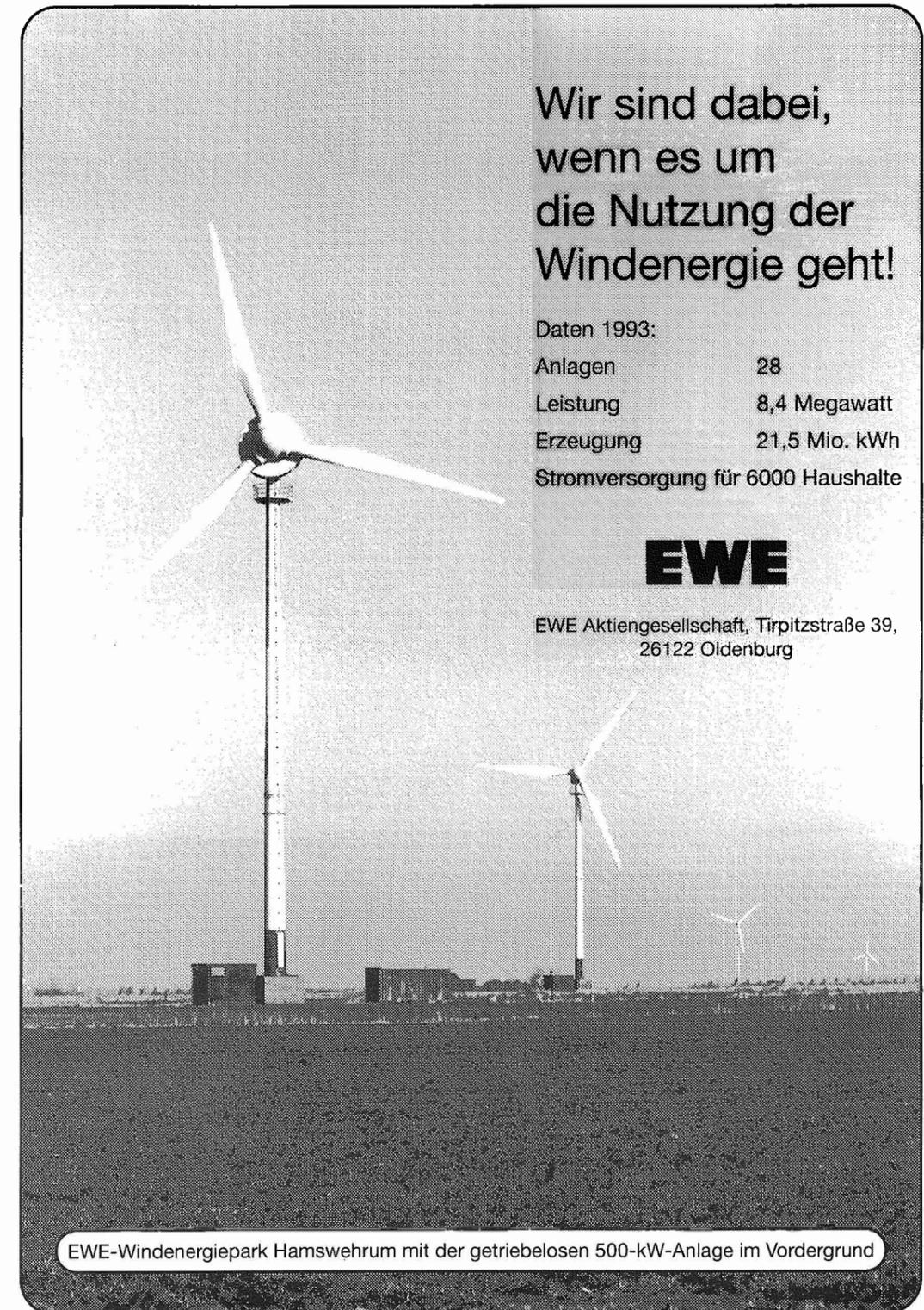
EWE-Windenergiepark Hamswehrum mit der getriebelosen 500-kW-Anlage im Vordergrund
