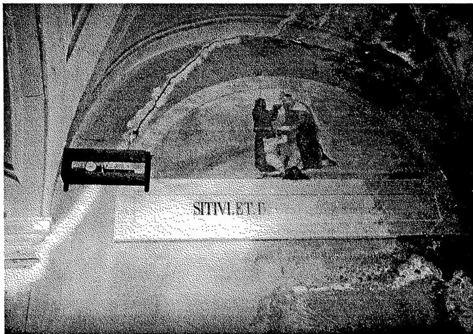
*Abbildung 1.1: Rein mechanisches Gerät zur Vermessung der Rißdynamik an einer Klosterinnenwand in Oberitalien.*
